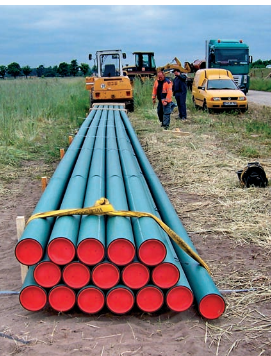
Bild 1: Anlieferung von 12 m Stangenware, SafeTech RC ®
