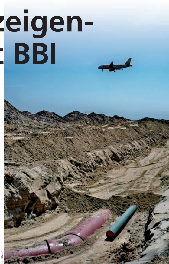
Bild 2: SafeTech RC ® , Verlegung am Flughafen BBI
