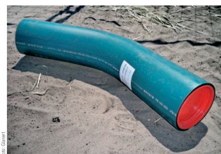
Bild 3: Bogenstück bereit zur Einbindung
