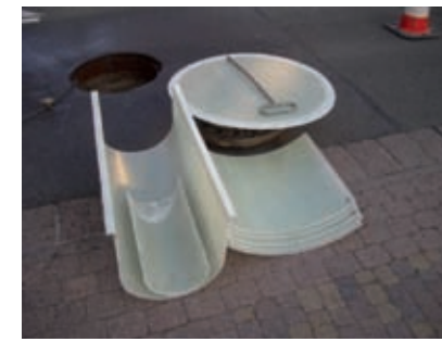
Vorgesehene Sanierung mit GfK-Auskleidung
