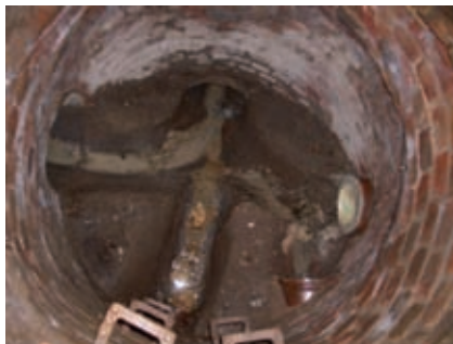
gemauerter Schacht
