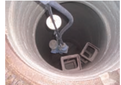
Maschinelle Beschichtung mit Mörtel
