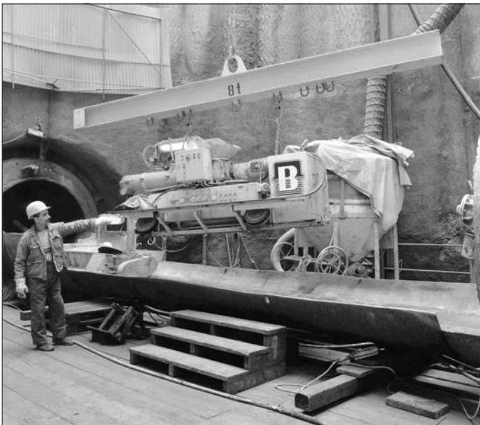
Bild 5: Einbau eines Durchlaufmischers auf die Einfahrkonstruktion
