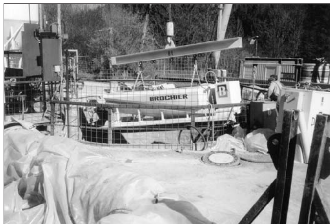
Bild 4: Der Trockenmörtelwagen wird in den Schacht herabgelassen
