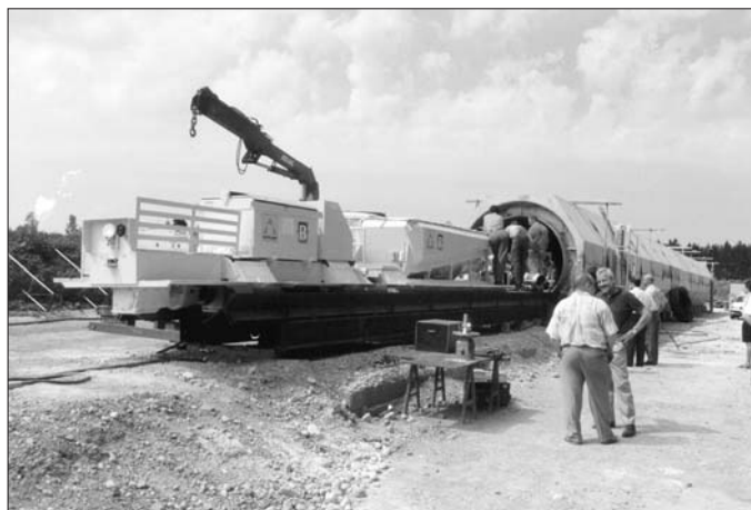
Bild 2: Aufbau des Großversuchs: E-Lok mit Trockenmörtelwagen auf der Einfahrkonstruktion
