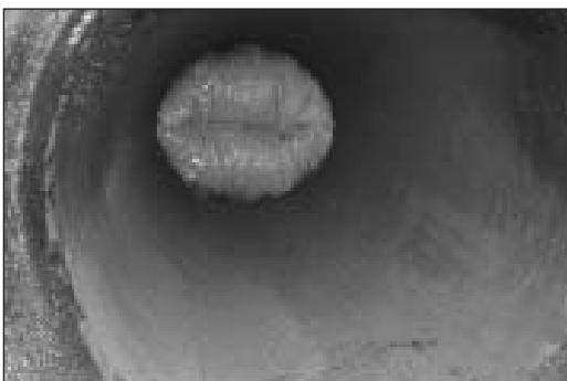
Eintreffen des Gewebeslauches in der Zielgrube
