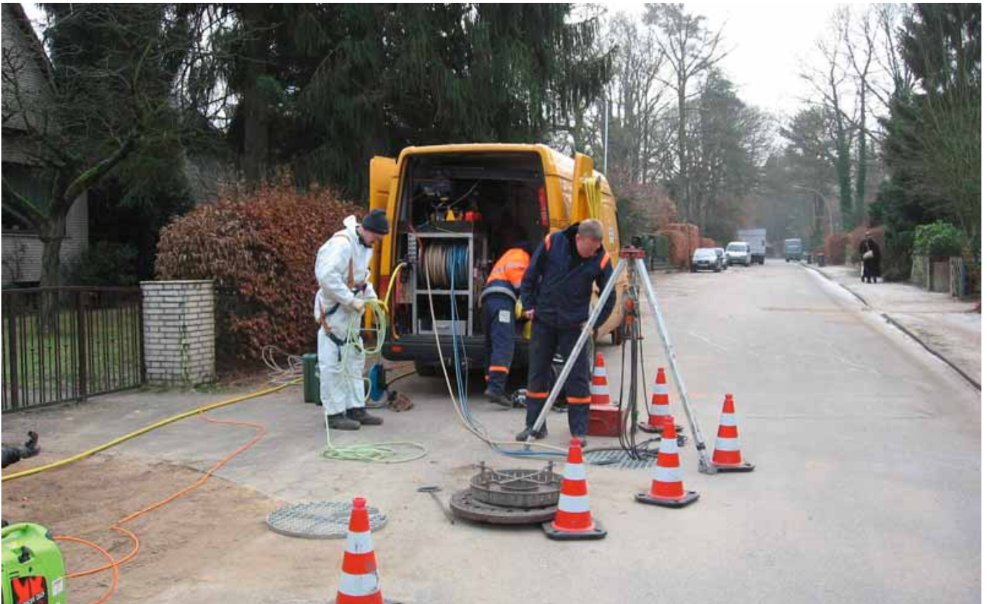
Kurzzeitige Einsätze wechselnder Firmen sind typisch für Renovierungsmaßnahmen – der Arbeitsschutz muss trotzdem immer eingehalten werden.
